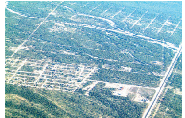
Líneas de gráfica proyectadas en la expectativa de futuro crecimiento. Plot lines laid out in expectation of future growth.
